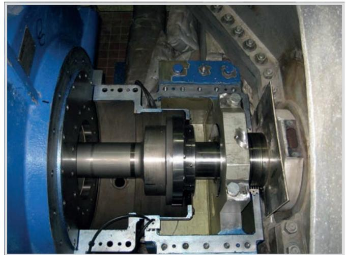
Bild 6. Einbau des Getriebes nach der Instandsetzung in die Anlage, Turbinenseite.
