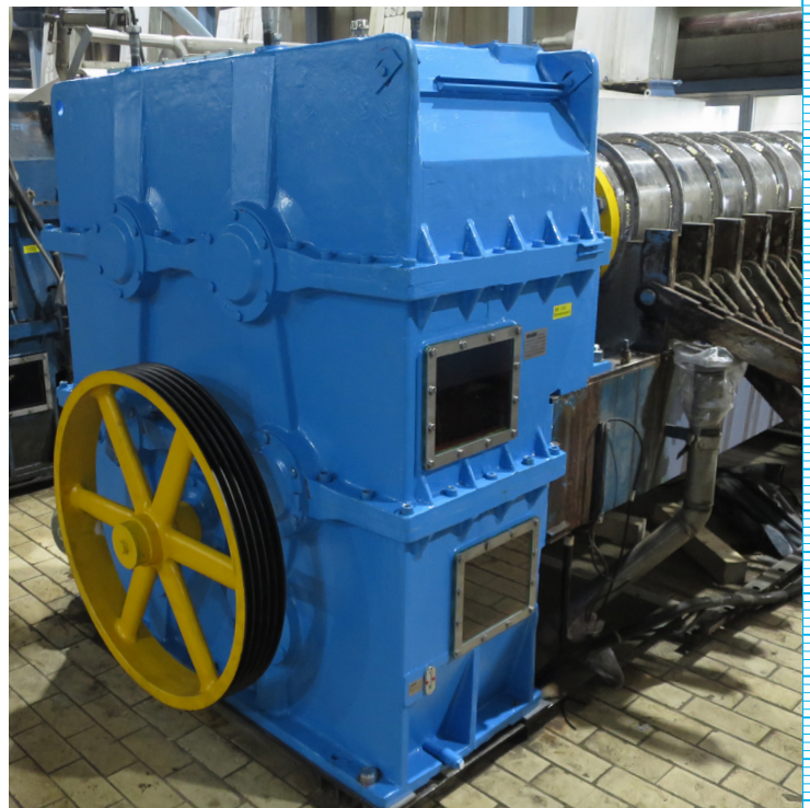
Eingebautes Getriebe der Schnitzelpresse nach der Instandsetzung bei BRAUER
